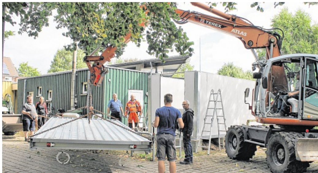
Gleich fertig: Das Dach wird aufgesetzt und schließt den Containeraufbau ab.
